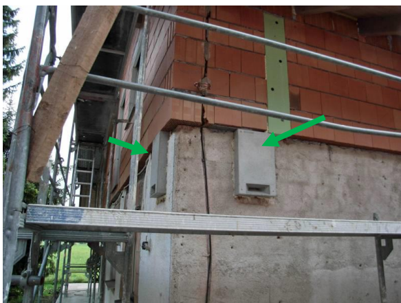
Einfamilienhaus mit zwei Quartieren für Fledermäuse, die auch zum Überwintern geeignet sind. Die Steine werden am Rohbau angebracht und sind nach Fertigstellung kaum mehr zu erkennen.
