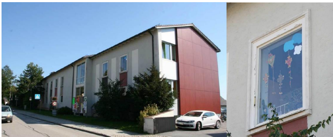
Grundschule in der Floßmannstraße vor der Sanierung
