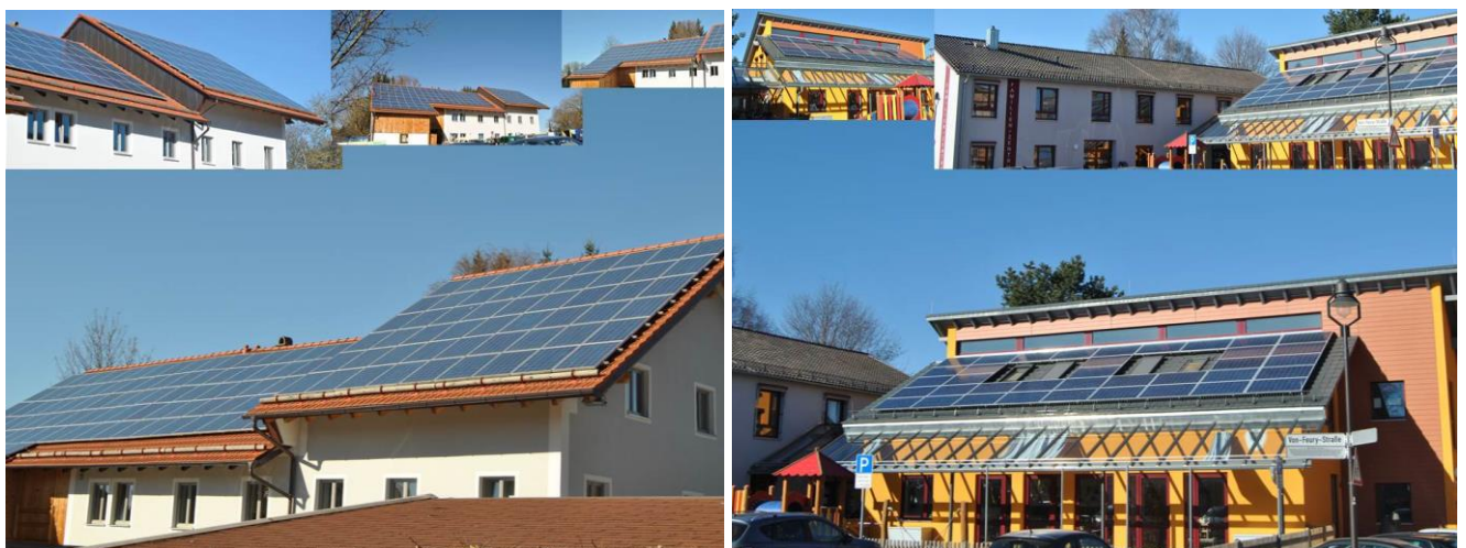
PV-Anlagen auf dem Dach des städtischen Bauhofes und des sanierten Gesundheitszentrums in der Von-Feury-Straße
