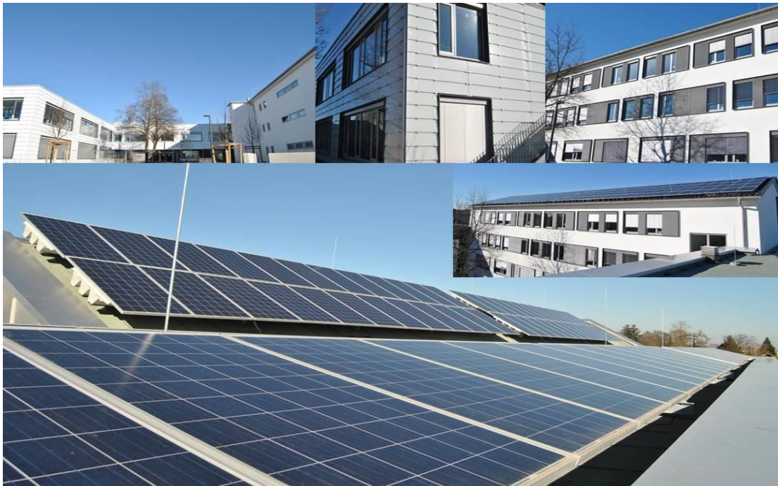
Grund- und Mittelschule in der Baldestraße nach der Sanierung
