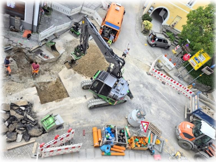
Archäologische Fachbegleitung und gleichzeitige TV Kanalerkundung, Hand in Hand mit dem Rohrleitungsbau:
