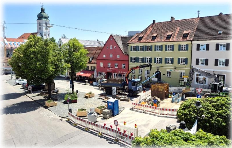
Die Anbindung der neuen Wasserleitung am Marienplatz, Bauabschnitt 1:
