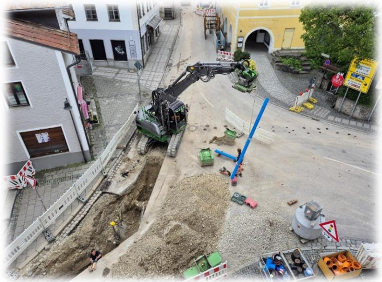
Rohrleitungsbau im Kreuzungsbereich Marienplatz/Heinrich-Vogl-Straße/Eberhardstraße:
