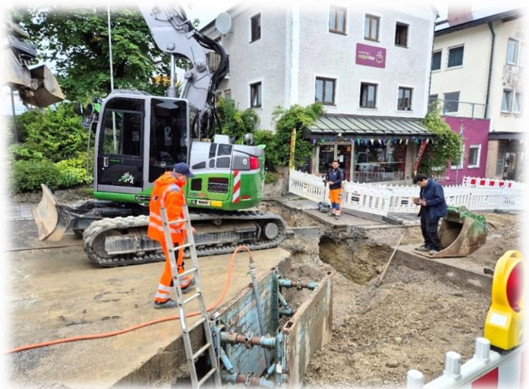
Bauabschnitt 2 im Bereich der Heinrich-Vogl-Straße mit archäologischer Fachbegleitung:
