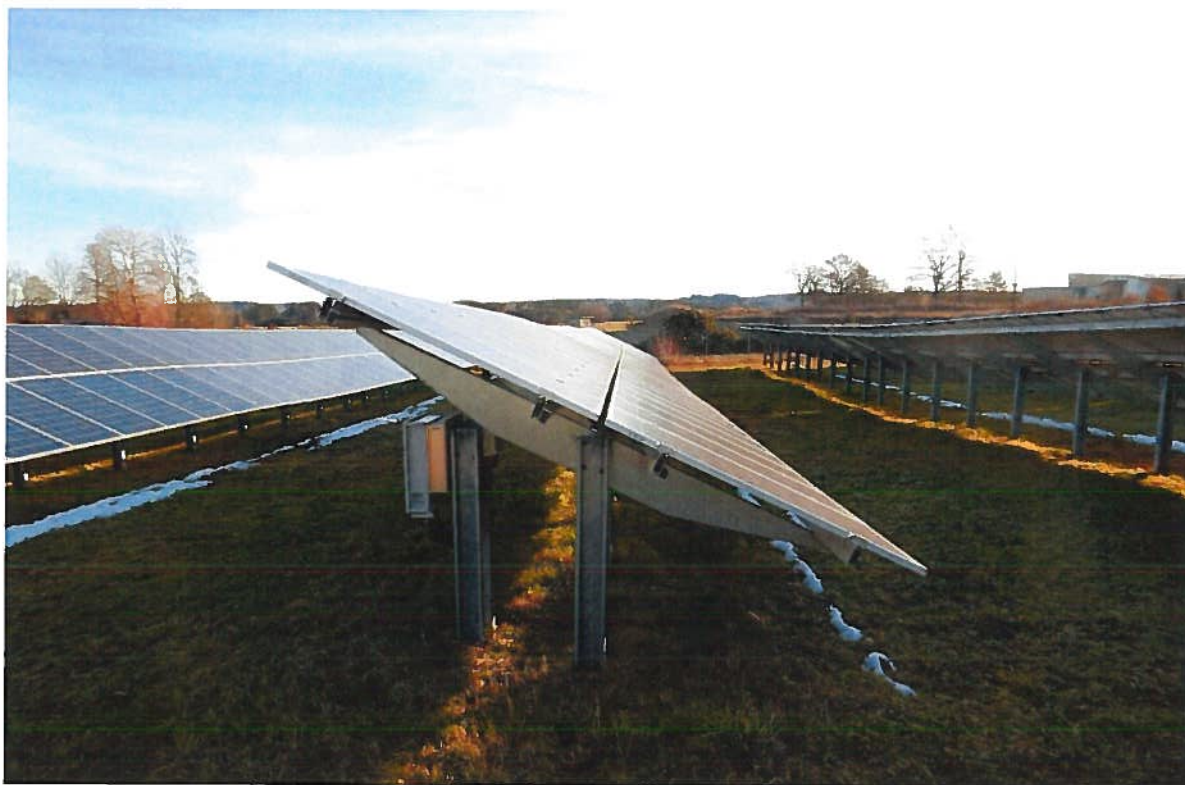
Abbildung 7: Beispiel für eine Freiflächenphotovoltaikanlage (Gemeinde Fuchstal)
