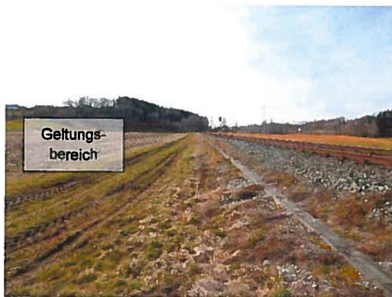
Abbildung 3: Blick von Nordosten nach Südwesten
