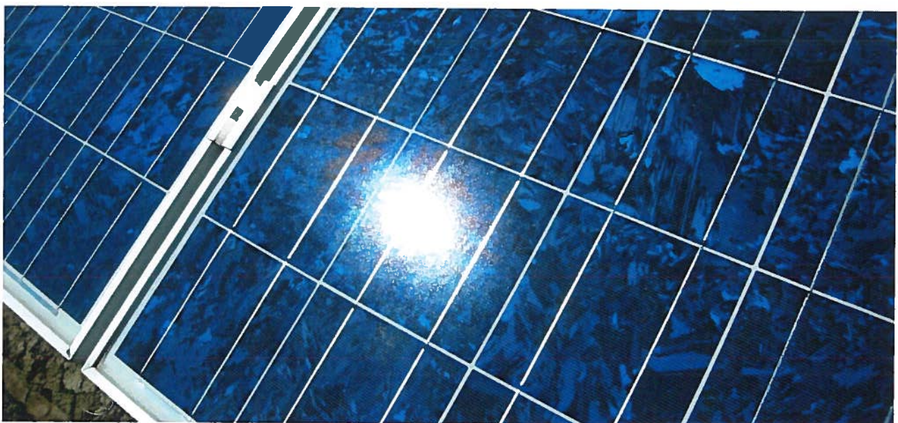
Bild 3.2.2: Diffuse Reflexion von direkten Sonnenlicht (Einstrahlung ca. 980 \text{ W/m}^2 ) auf einem PV Modul (Quelle: SolPEG)
